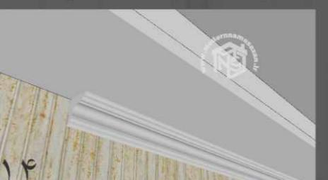
به مانند سایر ابزارها پس از چسب کاری ابزار فینیله، آنرا به نقطه نصب برد و تا گیرایی اولیه چسب بوسیله میخ ابزار را به کنج نیوار و ابزار کفی اتصال دهید.
