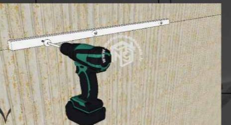
تا گیرایی اولیه چسب اقدام به اتصال مکانیکی توسط پیچ نمایید. در برخی نیوارها نیاز به به متنه کاری و نصب رول پلاک نیز می‌باشد.
