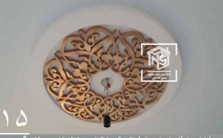
۱۵ شایان به ذکر است مراحل اتصال مکانیکی، بتونه کاری و لکه گیری مربوط به محصولات با وزن بالا و یا در سقف های تا هموار در زمانی که چسب گيرایی مناسبی با سقف بوجود نمی آورد انجام می شود و در شرایط ایده آل نیاز به اجرای این پروسه ها نمی باشد. همچنین این نوع روش نصب تنها یک روش پیشنهادی می باشد و روش های مرسوم دیگر نیز برای نصب این قبیل از محصولات نیز وجود دارد.
