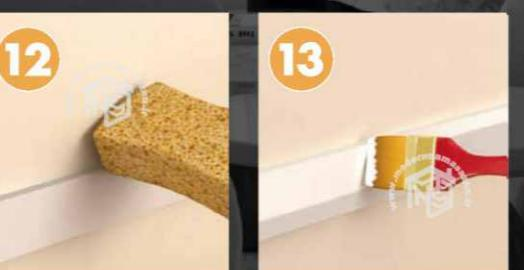
با توجه به نوع محصول شروع به پخش کردن ابزارهای روی سطح ابزار نمایید، توجه داشته باشید تا گیرایی اولیه چسب در صورت نیاز از میخ یا پیچ یا اسکوب پایه استفاده نمایید.
