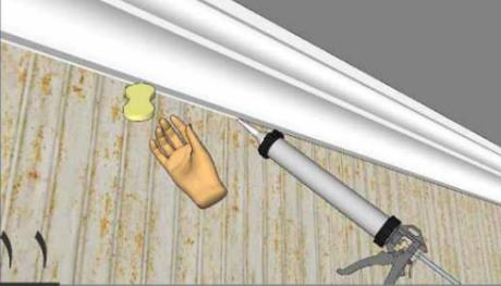
پس از نصب ابزارها حد فاصل میان دیوار و ابزار را با ماستیک (اکریلیک) درز گیری نمایید. بلافاصله پس از هر بار پروسه درز گیری توسط یه اسفنج مرطوب اضافات ماستیک را پاک نمایید.
