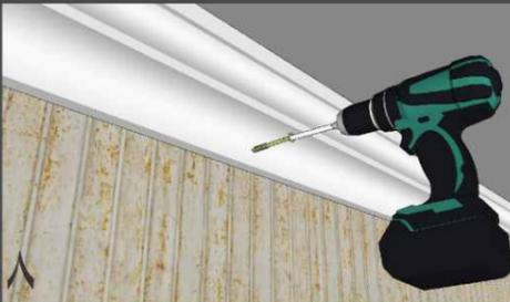
در برخی دیوارها نیاز به پیچ کردن و یا مته کاری و نصب رول پلاک نیز می باشد.
