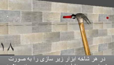
در هر شاخه ابزار زیر سازی را به صورت پیش فرض در نقطه نصب برده و پس از علامت گذاری بر روی دیوار اقدام به سوارخ کردن با مته و نصب رول پلاک نمایید.
