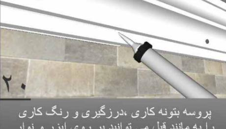
پس از پیچ کردن نوار زیر سازی به دیوار به مانند پروسه های قبل اقدام به نصب ابزار نور مخفی نمایید در این مرحله تاگیری اولیه چسب می توانید ابزار را بوسیله میخ مهار نمایید.
